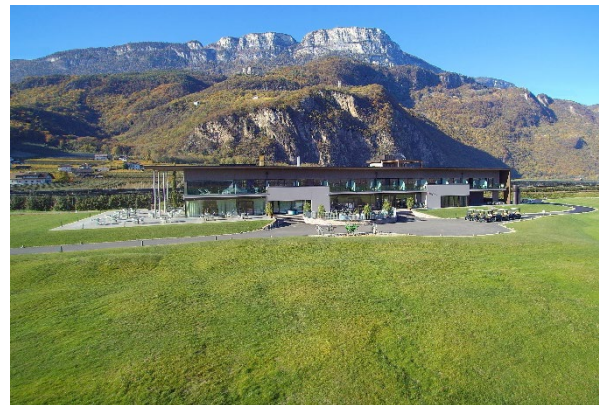
Bild 4: Nach der Beschleunigung kommt die Entschleunigung – Partnerhotels von Driving Experience Südtirol (Quelle: The Lodge)
